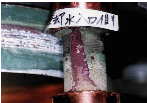
図3：入力結合器高周波窓の内導体冷却水路に起きたエロージョン・コロージョン。流れに沿った侵食跡が見られる (材質：無酸素銅)。
